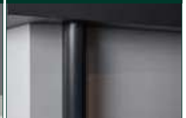
Integrierte Dachrinne / 1 Fallrohr
