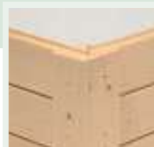
Steck-Schraub-Variante 28 oder 40 mm Bohle
