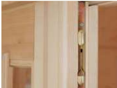
Leimholztüren mit Softlinekanten, 42 mm
