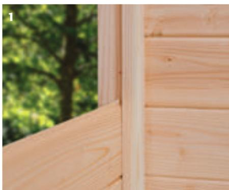
**1.** Die Zaunpfosten werden im Abstand von 177 cm (lichte Weite) gesetzt. Dabei müssen die Laschen der Pfostenanker nach vorne und hinten zeigen. Die Steckzaun-Bretter schieben Sie in die Nuten der Pfosten. Hierbei ist die Feder des Brettes nach oben gerichtet (Wasserablauf). Das unterste Brett sollte ca. 3 cm von der Pfostenunterkante beginnen.
